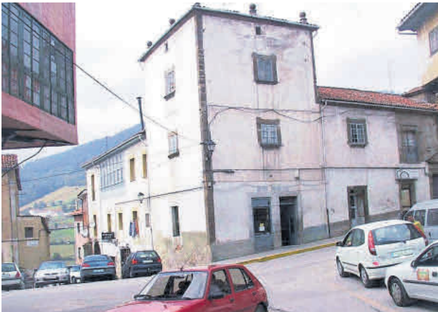
Dos imágenes del Palacio de Merás, en Tineo, antes y después de su restauración en el año 2008.
